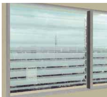
由具有菲涅尔透镜特征透明百叶窗所制成的发电窗,它可将直射太阳光聚焦到发光条上,并进一步将其聚焦到位于框架上的PV电池上,其漫散射光则用来作为房间内的照明。(图片来自于Solarstructure公司)
